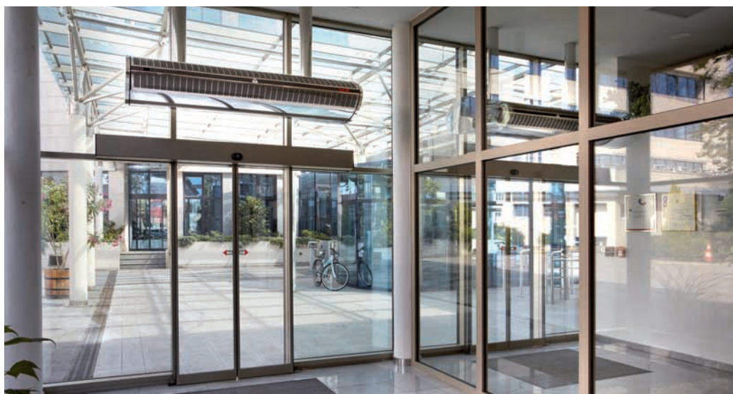
Центральный вход Пивзавод Budvar Nucleo
