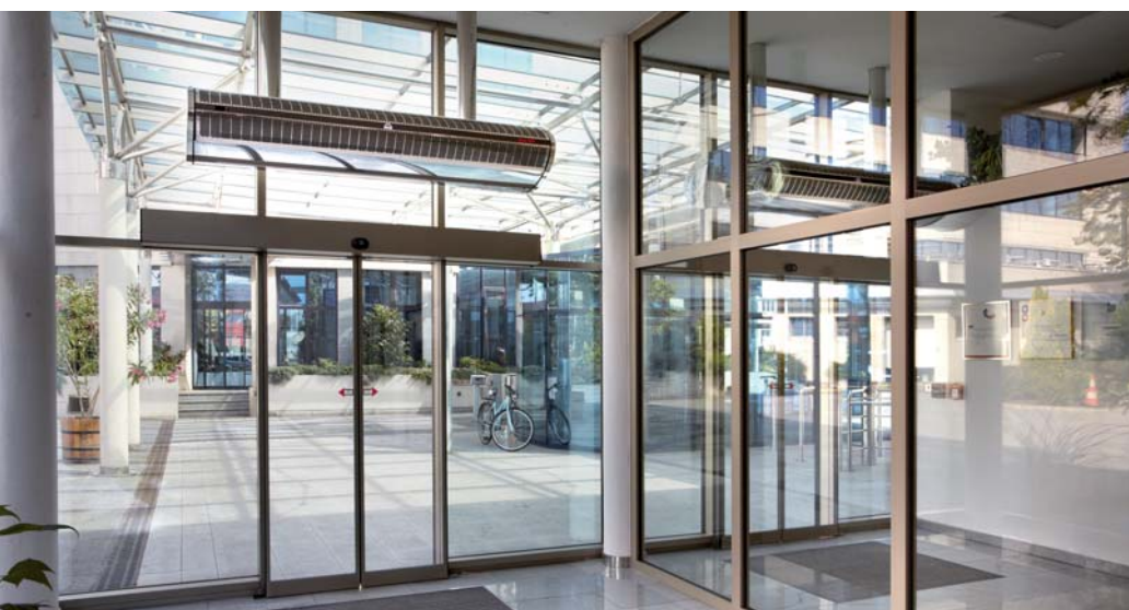
Центральный вход Пивзавод Budvar Nucleo
